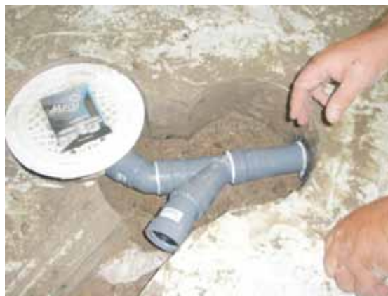
Golvbrunn och rördelar färdigmonterade Här har man valt att ansluta en golvbrunn med 50 mm utlopp för att kunna ansluta till den befintliga ledningen med en gumminuff. Detta förfarande är mycket kostnadseffektivt. En ledning för tvättmaskinsavlopp har anslutits till ledningen för den nya golvbrunnen.
