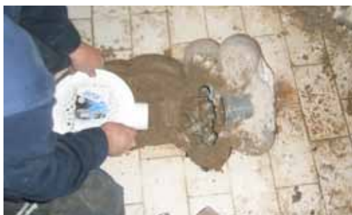
Utprovning av golvbrunn.
