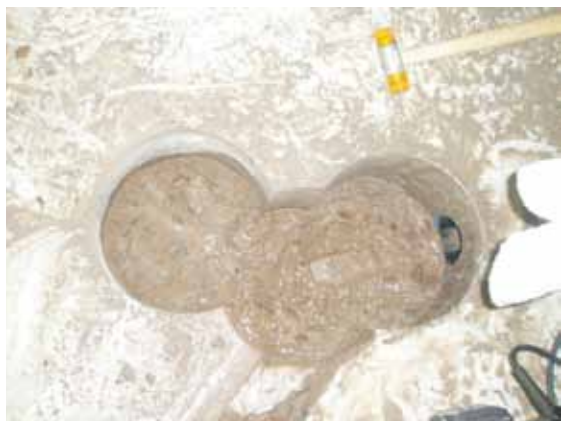
Kärnborringen klar. En gumminippel har monterats i rörände.
