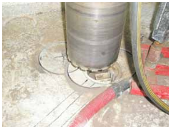
Kärnborring för demontering av golvbrunnen.
