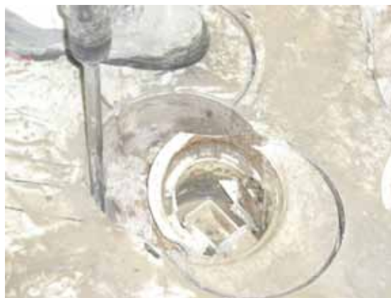
Demontering av golvbrunn och betongdelar.
