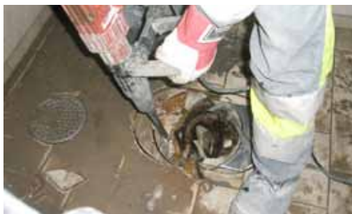
Borttagning av kärnborrade hål-i-hål segment.
