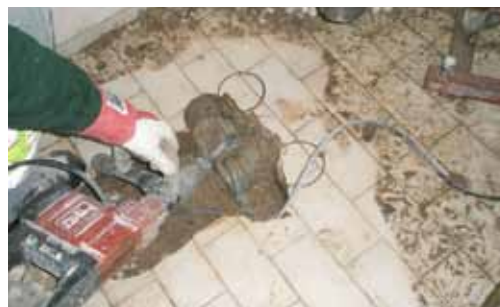
Frambilning av rörände med muff.
