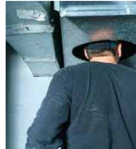
Pågående OVK kontroll
