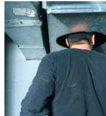
Pågående OVK kontroll
